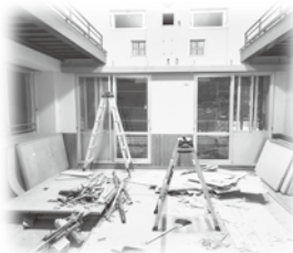
本体施設改修中
