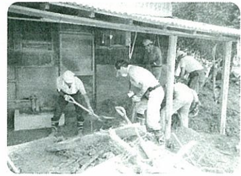
家屋周辺の土砂撤去作業
